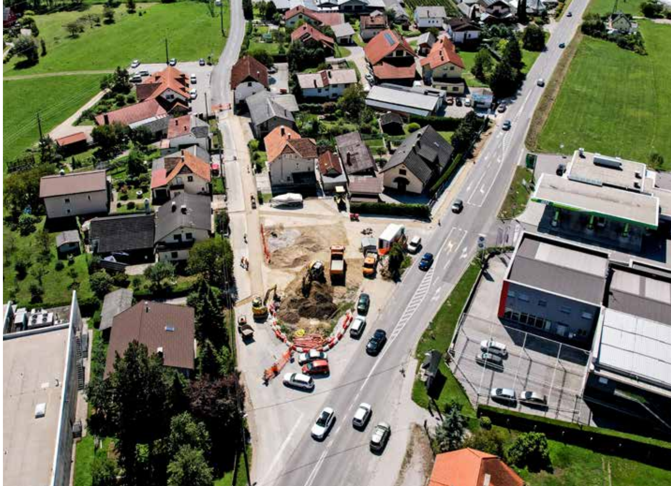
Pogled na gradbišče v Arclinu
