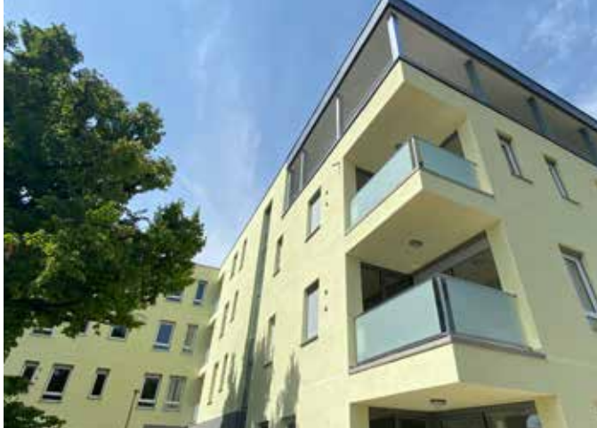
Nova izolativna fasada, moderna oprema balkonov in kakovostno stavbno pohištvo in še več - ponujajo izboljšanje kakovosti bivanja.
