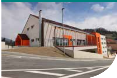
Izgradnja vrtca Frankolovo
