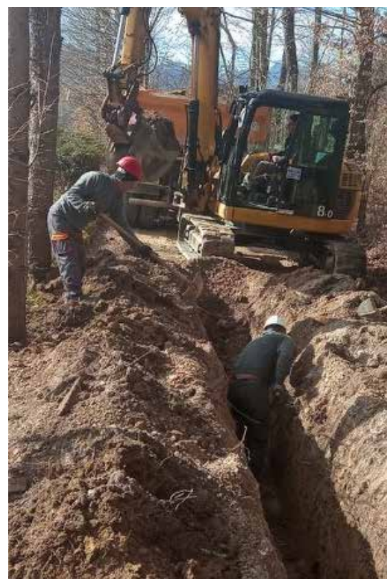
Izgradnja kanalov na projektu Aglomeracija Vojnik
