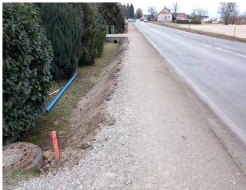
Obnova magistralnega vodovoda ob Celjski cesti
