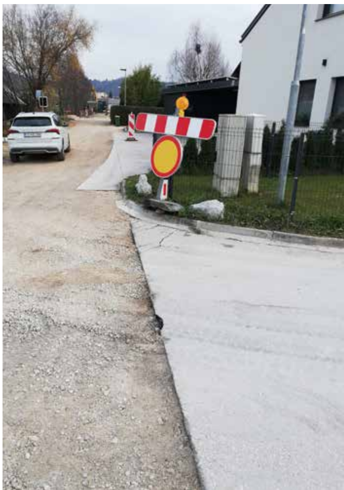
Pogled na Arclinsko cesto med gradnjo
