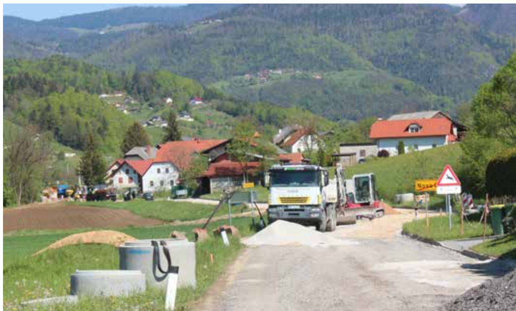
Na gradbišču med Razdeljem in Novo Cerkvijo
