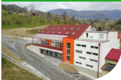
Izgradnja vrtca Frankolovo
