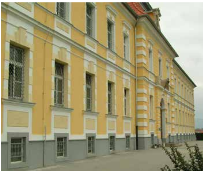
Pročelje stare stavbe bolnišnice
