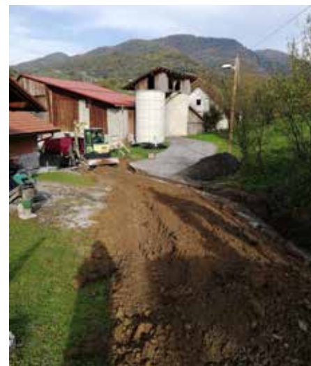
Gradbena dela na vodovodu Trnovlje pri Socki.
