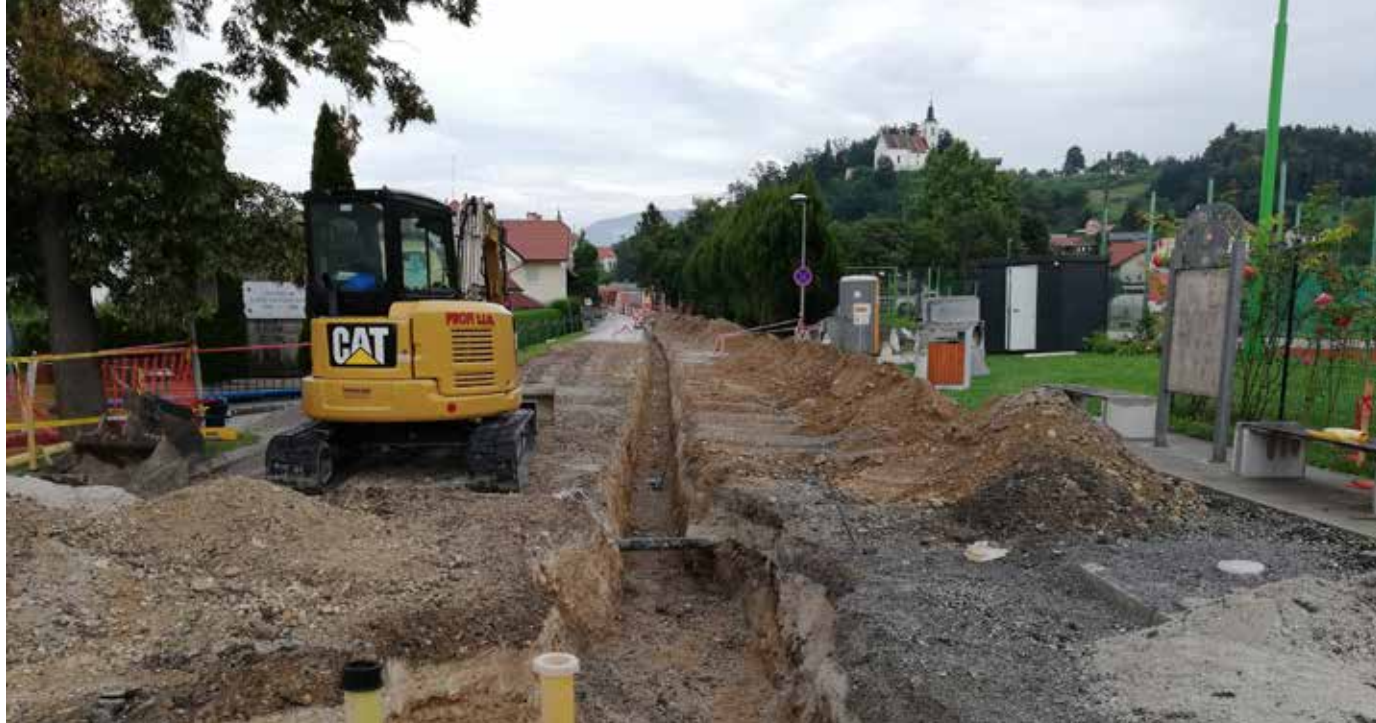
Dela na Keršovi ulici v Vojniku
