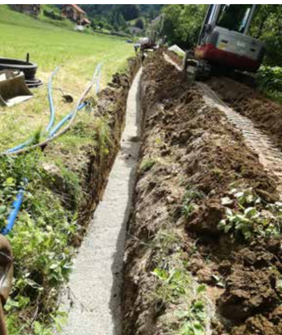
Vodovod Brdce - 2. faza
