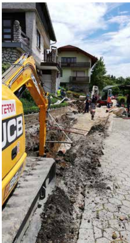
Rekonstrukcija Kašove ulice
