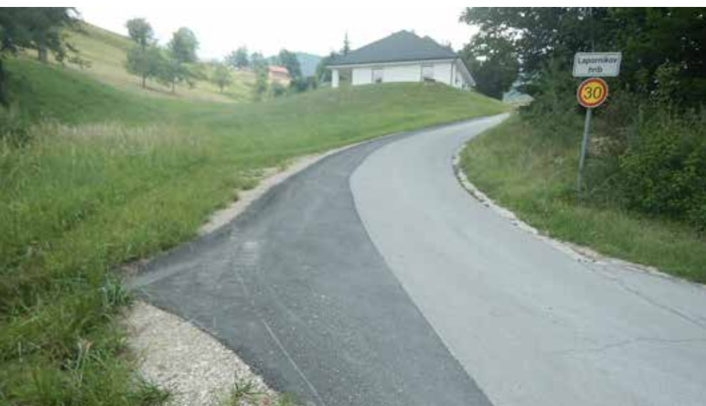
Sanacija vozišča z razširitvijo in izdelavo cestne mulde v Dolu pod Gojko
