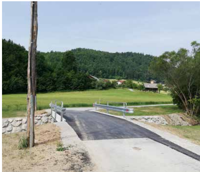
Most v spodnji Hrenovi omogoča varen prehod čez Dobrnico
