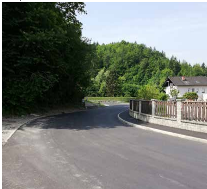
Obnovljena lokalna cesta v Ivenci
