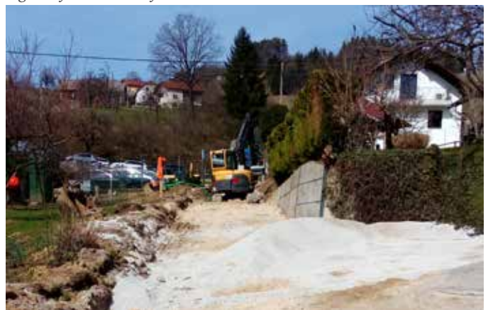
Izgradnja kanalizacije na Frankolovem
