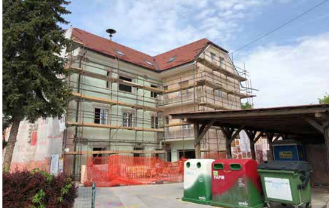
V okviru rekonstrukcije in spremembe namembnosti objekta se je izvedla tudi energetska sanacija objekta.
