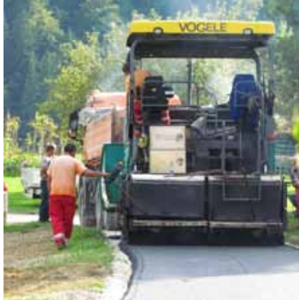
Asfaltiranje ceste Ilovca (Kolar, Pilko)
