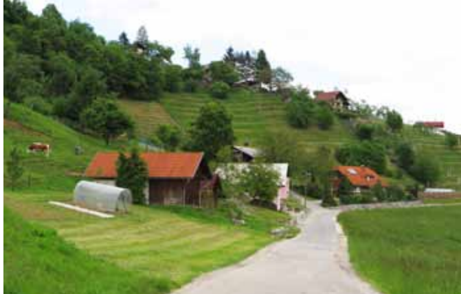
Občina Vojnik je pristopila k projektu sanacije plazu Bovše in obnovi lokalne ceste.
