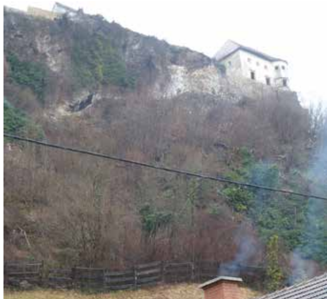
Sanacija zevajoče razpoke pod gradom bo dolgotrajna in draga, zato brez državne pomoči ne bo šlo.
