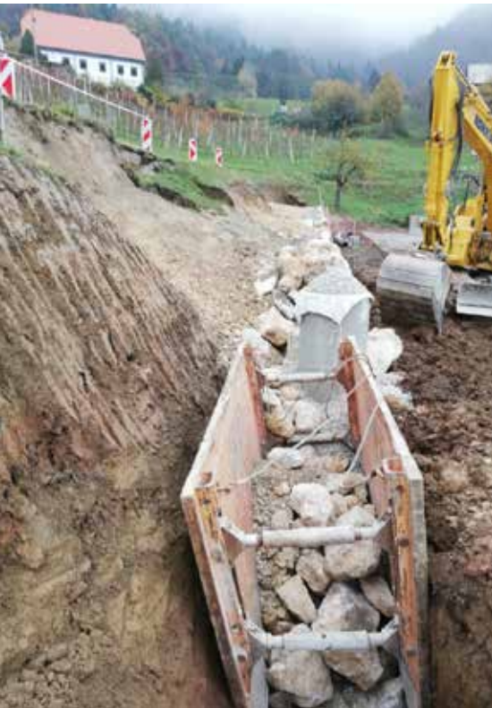
Sanacija v Črešnjicah
