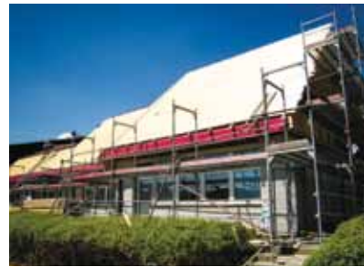
Sanacija strehe Druge osnovne šole Slovenj Gradec
