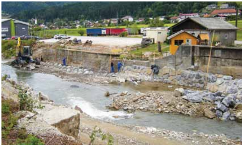
Sanacija vodotokov po poplavih
