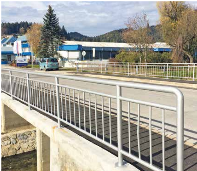
Prenovljeni most čez Suhodolnico za lepši izgled mesta in mimoidočim v veselje
