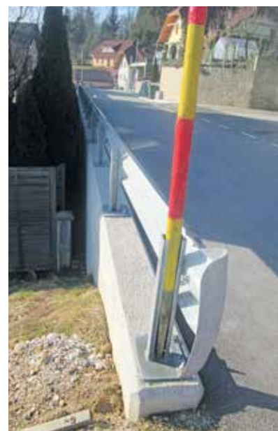
Oporna stena v Brezovi vasi – gradnja infrastrukture na strmih in plazovitih območjih je tehnično zahtevna.
