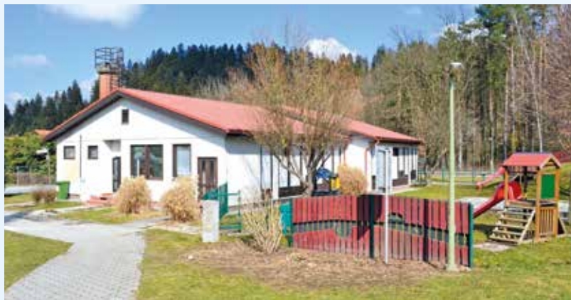
Že jeseni bo na mestu stare zgradbe otroke in vzgojiteljice sprejel nov lesen vrtec.
