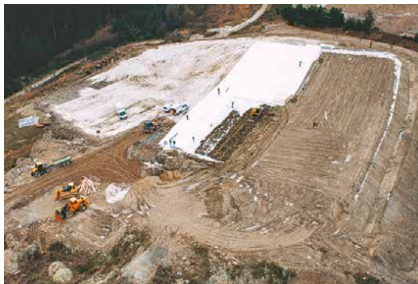
Izvajanje gradbenih zapiralnih del na odlagališču v Mislinjski Dobravi leta 2016.
