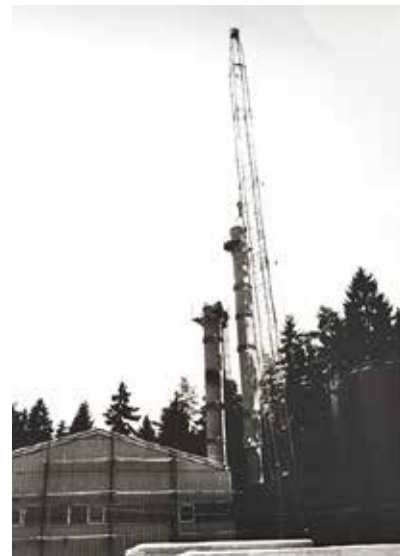
Dimnik toplotarne; gradnja mestne kotlarne na Štibuha leta 1979
