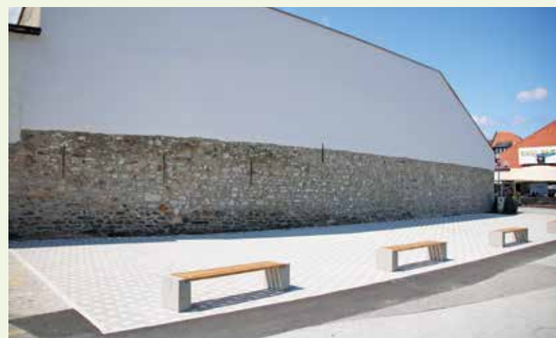
Obnovljen zid na Meškovi ulici (foto Grega Andrejc)
