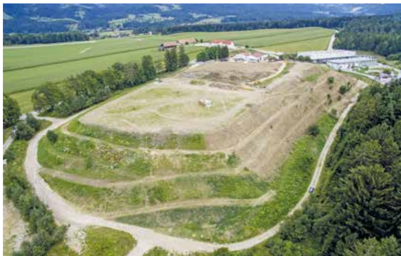
Izvajanje zapiralnih del na odlagališču v Mislinjski Dobravi, avgust 2017 (foto Žiga Andrejč)
