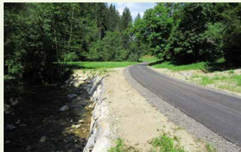
Rekonstrukcija ceste Gaberke Velunje
