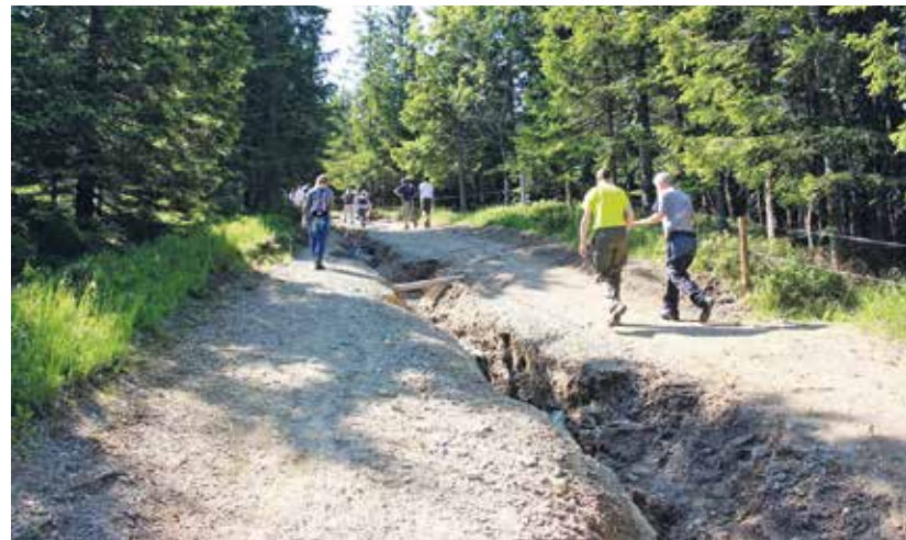
Erozijski jarek vzdolž poti s Pungarta na Ribniško kočo, ki je nastal kot posledica poškodovanj prečnih prekopov ob vožnji z motornimi vozili (motorji in štirikolesniki). (arhiv ZGS)
