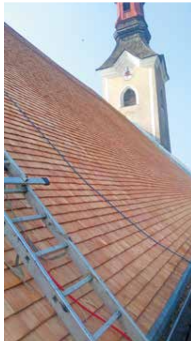
Nova streha iz macesnovih škodel (foto Matija Pečoler)
