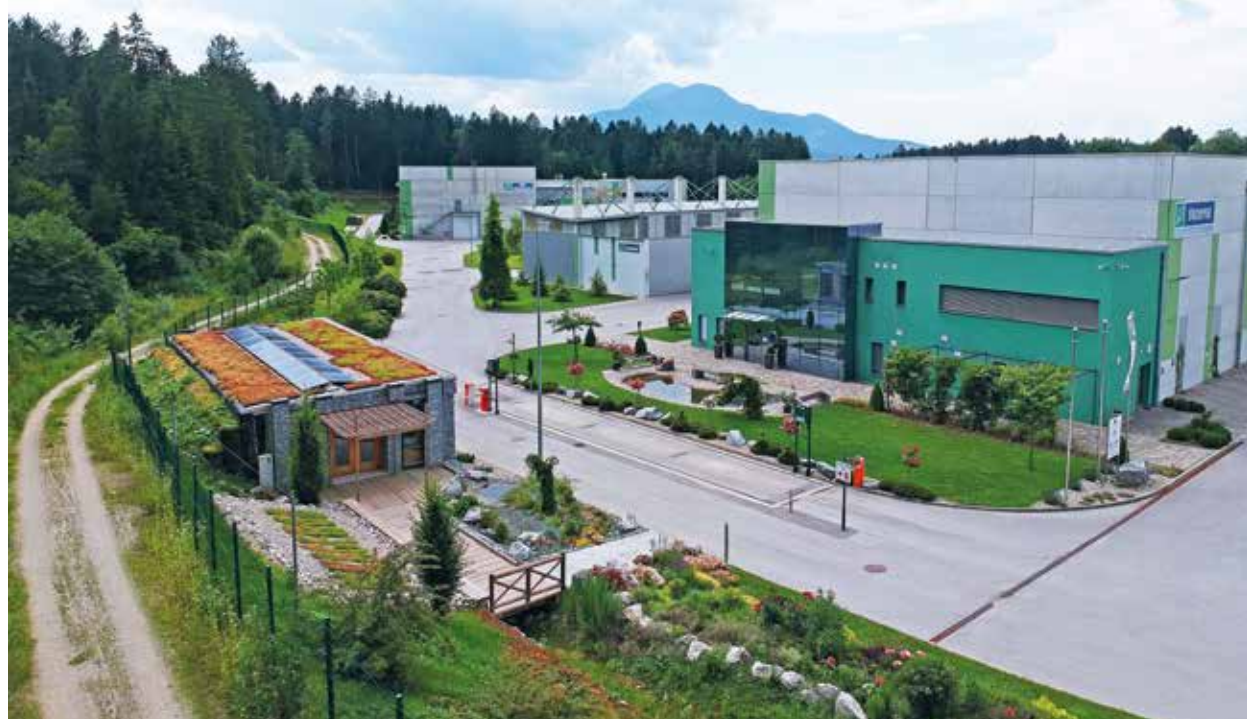
Regijski center za ravnanje z odpadki Kocerod v Mislinjski Dobravi (foto Tonček Hozjan)
