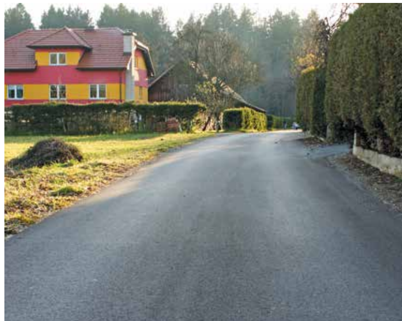
Asfaltirana cesta Hujek-Matavž
