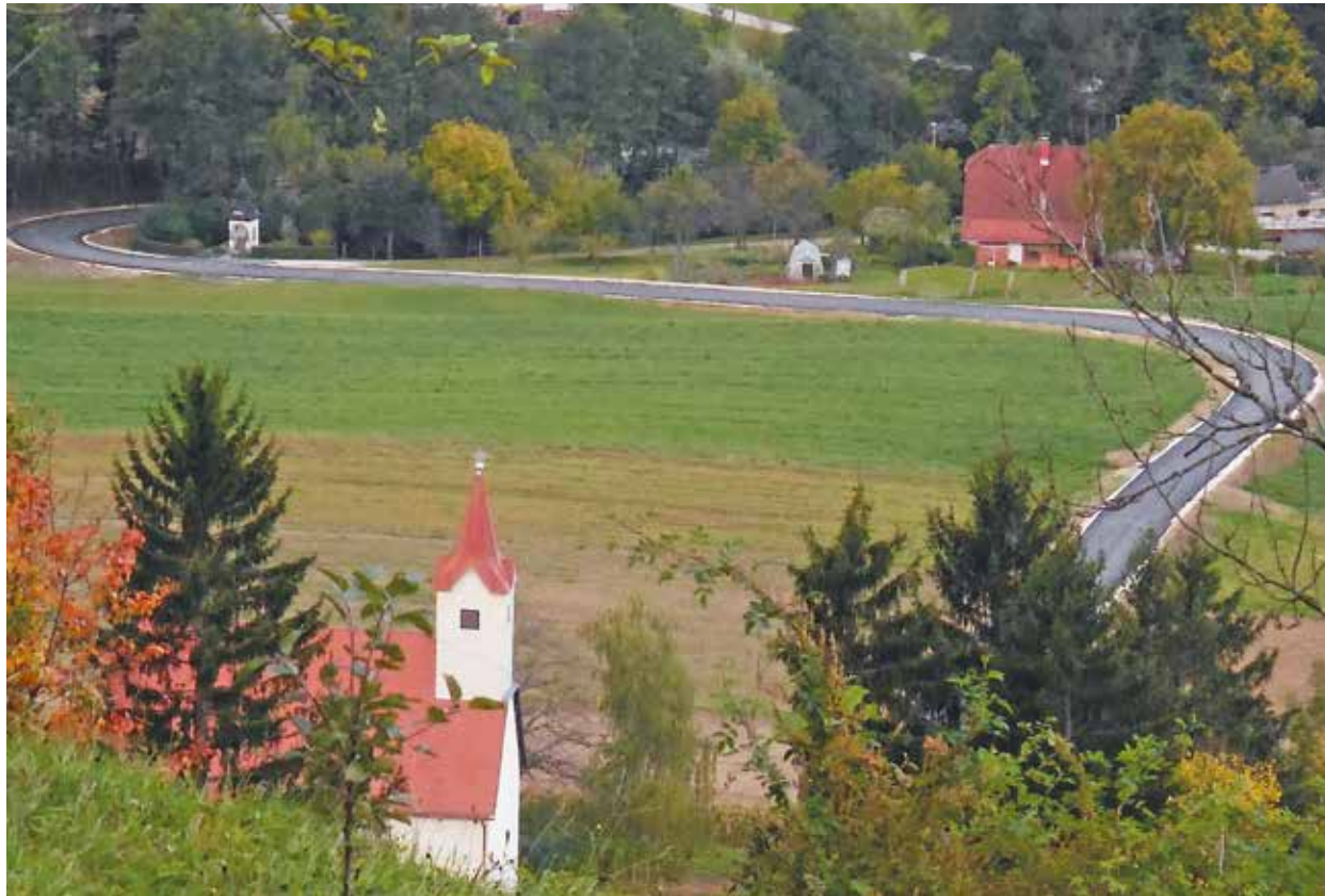
Asfaltirana cesta Brda-Dovže, nova pridobitev v VS Turiška vas (foto K. Kolar)
