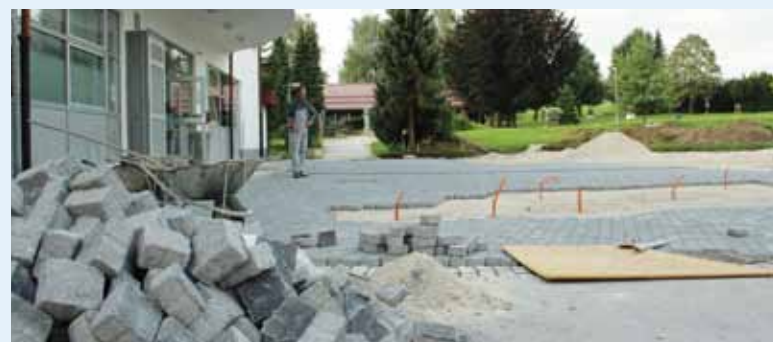
Glavnina gradbenih del na šolskem parku je bila izvedena v poletnih mesecih.
