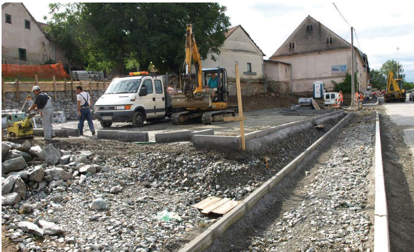
Gradnja parkirišča pri pošti
