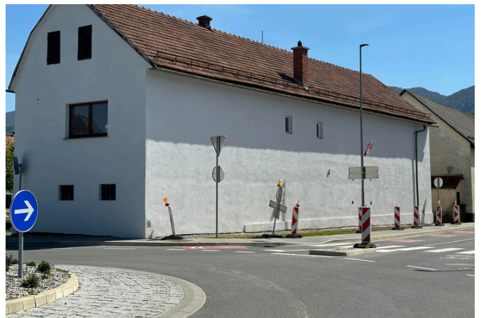
Obnovljena fasada medgeneracijskega centra
