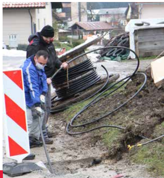
Delavci Elektra pri polaganju električnih kablov v ulici Pod gradom
