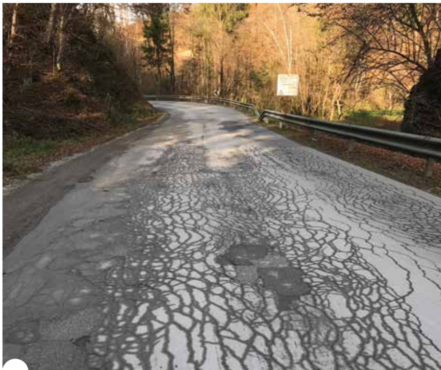
Obnovitvena dela na regionalni cesti Polzela-Velenje so prepotrebna.
