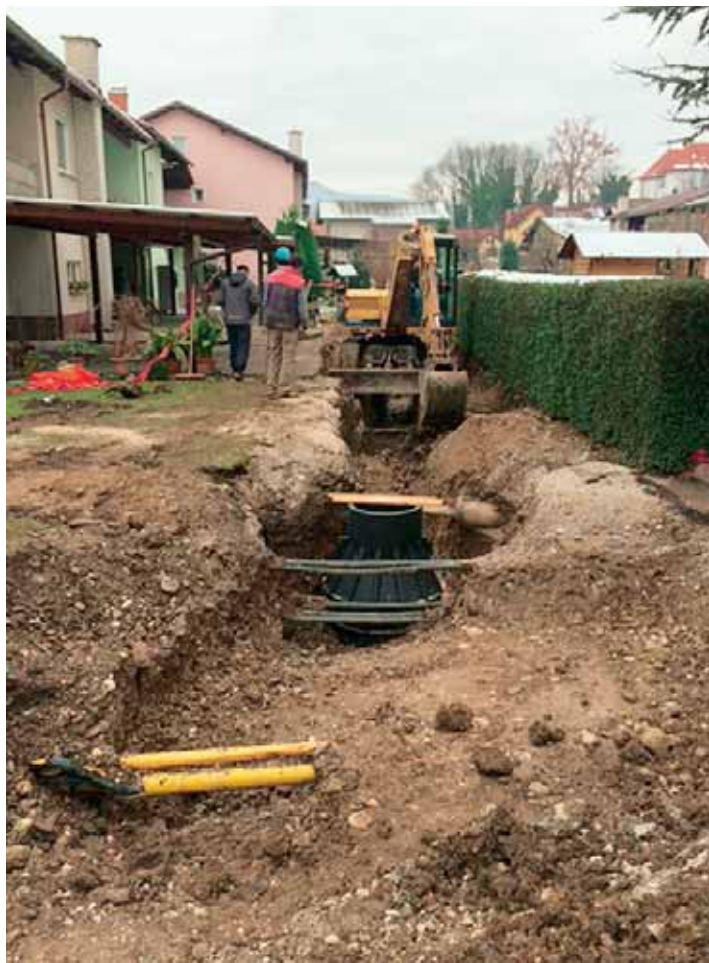
Izgradnja kanalizacije pri vrstnih hišah na Polzeli.
