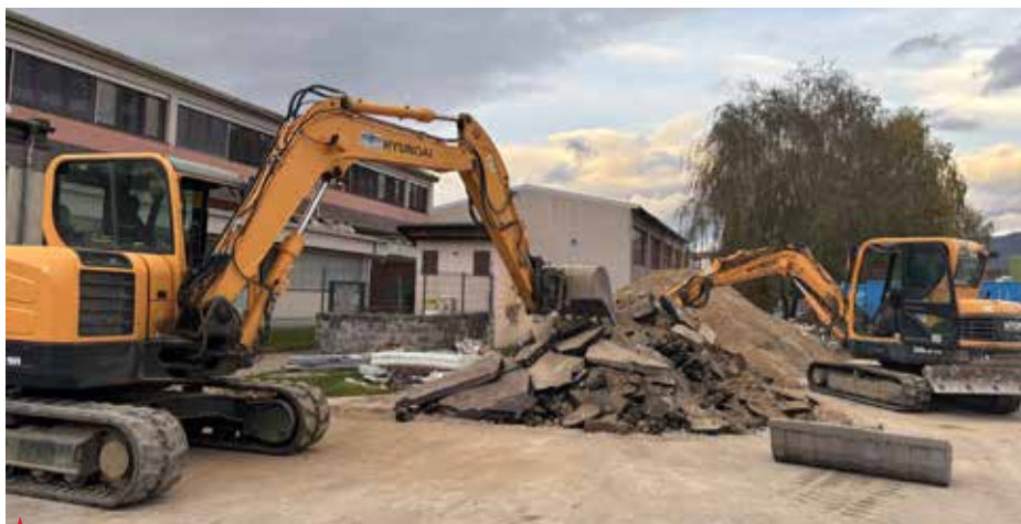
➤ Pred šolo potekajo pripravljalna dela za gradnjo prizidka, ki bo učencem zagotovil sodobne in prijetne učne prostore.
