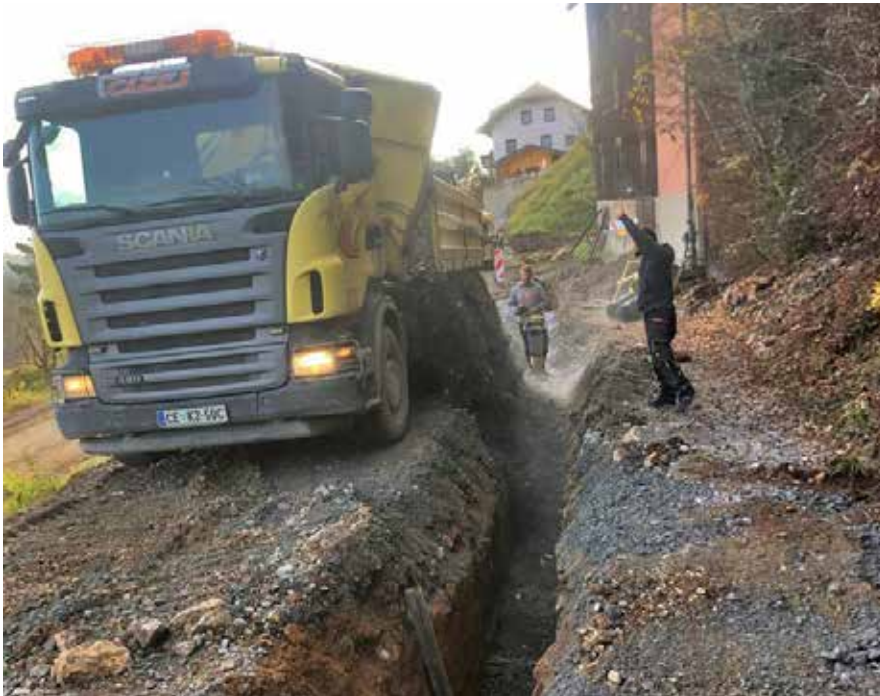
Ureja se še zadnji odsek ceste.
