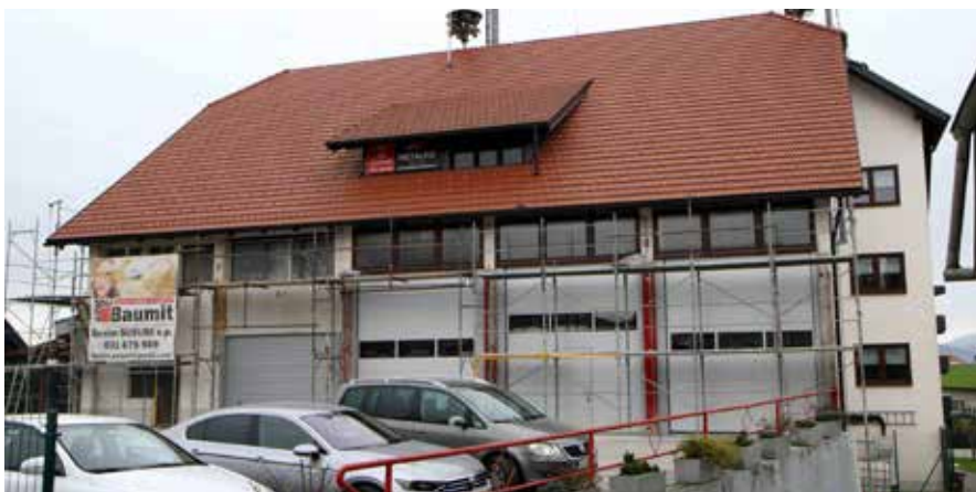
Dela pri izolaciji fasade
