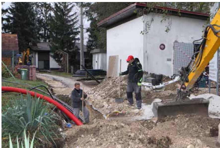
Obnova vodovoda na Brinski cesti v Ločici ob Savinji
