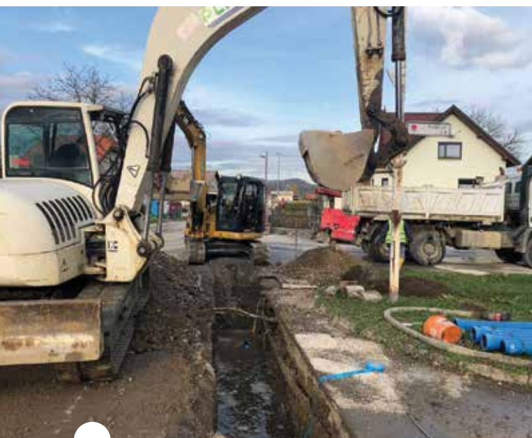
Vodovod bo obnovljen v dolžini 350 metrov.
