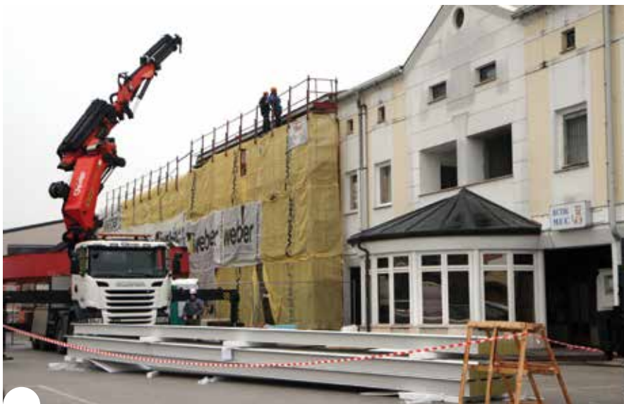
Energetski sanaciji športne dvorane bo sledila še energetska sanacija vrtca.
