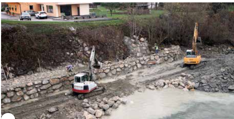
Dela pri zavarovanju leve brežine nad mostom čez Savinjo (Polzela-Parižlje)
