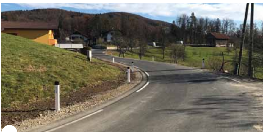
Obnovljena cesta, ki vodi do Doma krajanov, je zdaj tudi varnejša.
