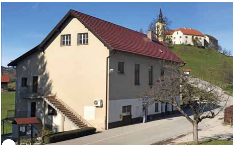
Nova streha na več kot 50 let starem objektu predstavlja del mozaika urejene podobe kraja.
