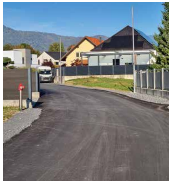
Obnovljenih je 250 metrov ceste.
