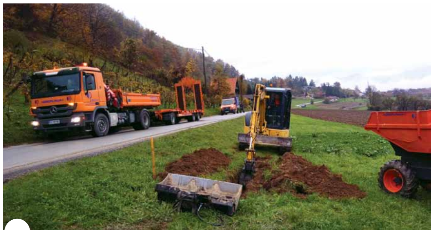
Pričetek del na trasi vodovoda v Podvinu
