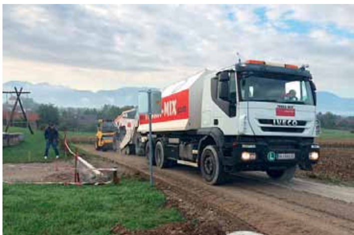
Prvi in drugi dan – izvedba sondažnih jam in zakoličba, ureditev odvojnjanja.
