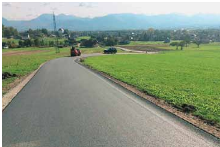
Tretji dan – asfaltiranje vozišča.
