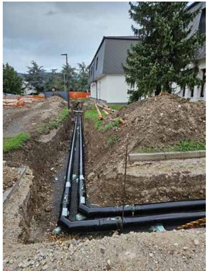
Novi del toplovodnega omrežja
