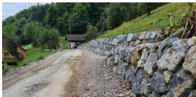
Brežine ceste se sanirajo s kamnitimi zložbami.
