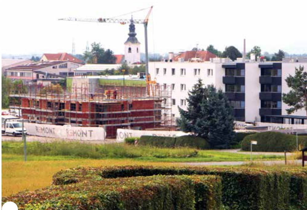
Gradnja 19 oskrbovanih stanovanj se je že začela.
