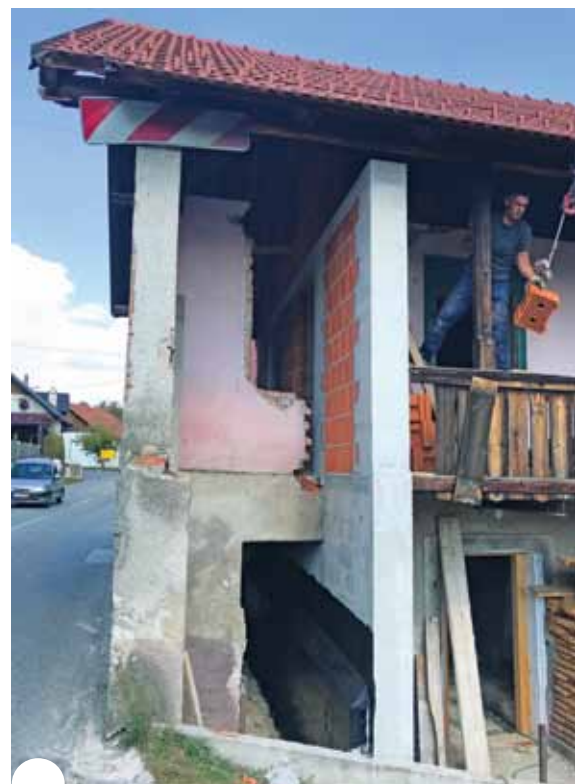
Zaradi izgradnje pločnika je treba porušiti tudi del gospodarskega objekta.
