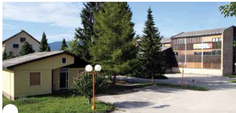
Upravna stavba s trgovino in gasilski dom
