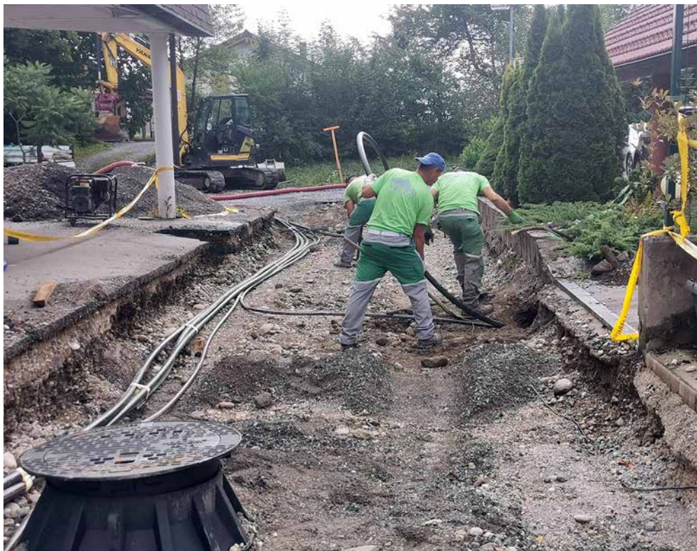
▲ Pri gradnji kanalizacije na Bregu pri Polzeli
