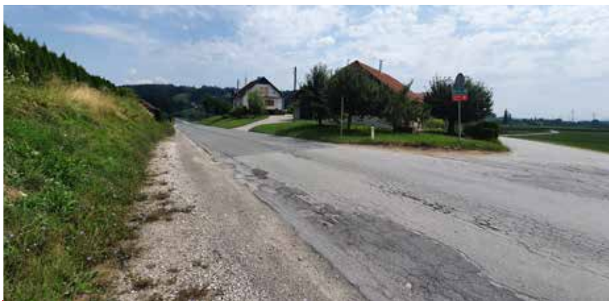
Pločnik bo v smeri Velenje-Polzela do križišča pri Trojčkih izveden ob desni strani vozišča v dolžini 623 m, nadaljevanje do Polzele po levi strani vozišča v dolžini 576 m.
