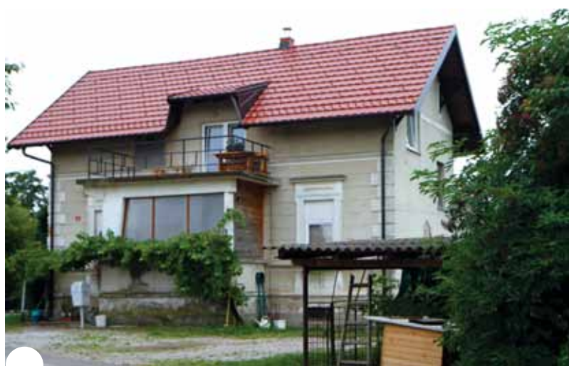
Stavba v Podvinu z novo streho
