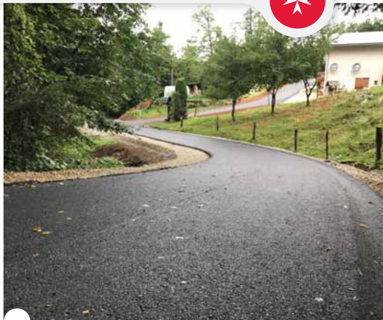
Kot prvi je obnovljen odsek lokalne ceste Skornšek v Podvinu.
