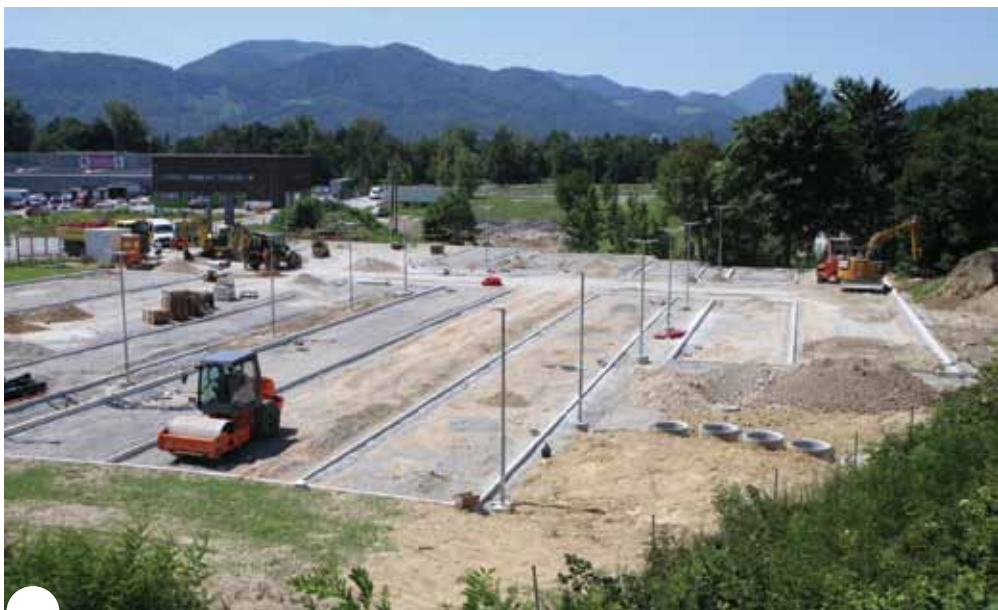
Gradnja parkirišč poteka po terminskem načrtu.
