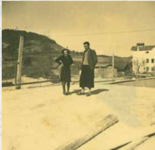
Medica Rojnik stoji na vlti plati novega mostu.
