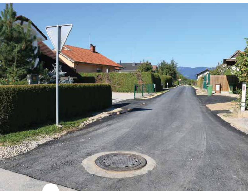
V letu 2015 je občina na novo zgradila tudi kanalizacijo v Ločici ter obnovila vodovod.
