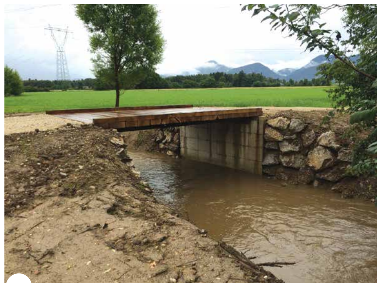
Most po obnovi
