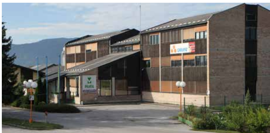
Upravna stavba bivše pohištvene industrije Garant Polzela
