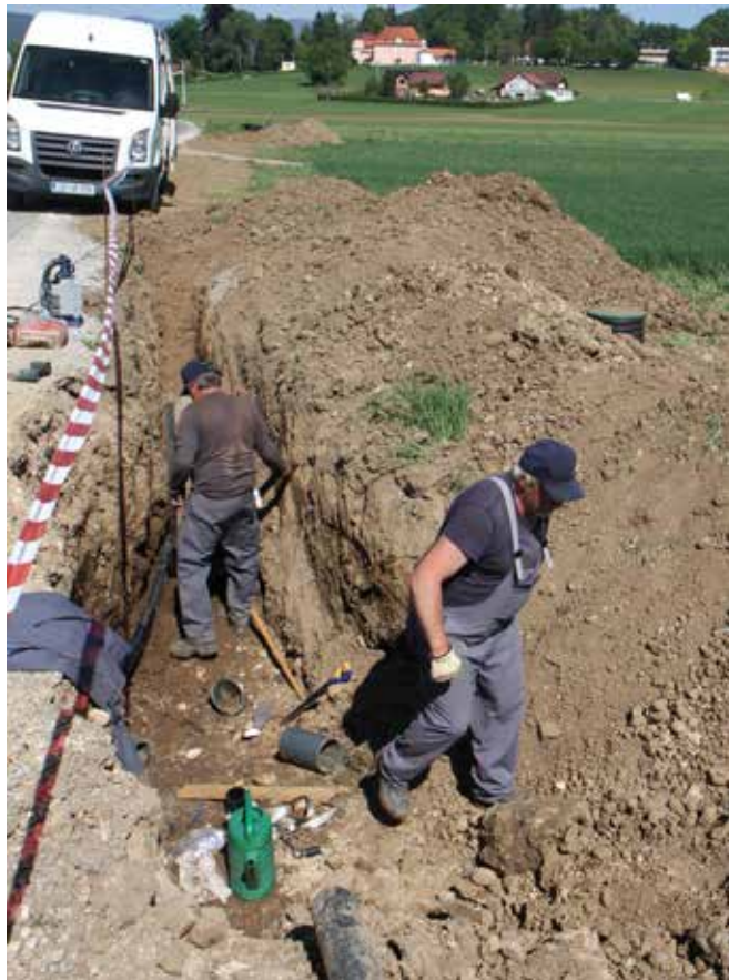
Pri obnovi namakalnega sistema Breg v Občini Polzela
