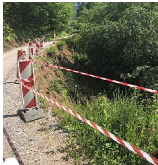
Plaz bo v skladu s projektom saniran v dolžini 30 metrov.
