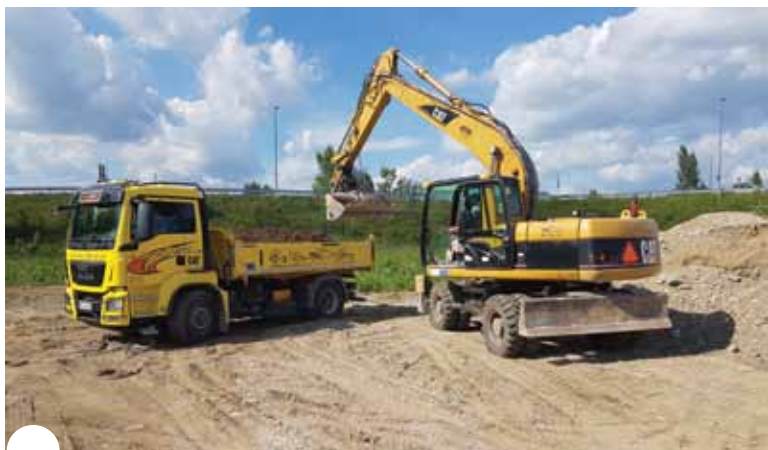
Parkirišče v Poslovni coni Ločica bo zgrajeno do septembra 2017.
